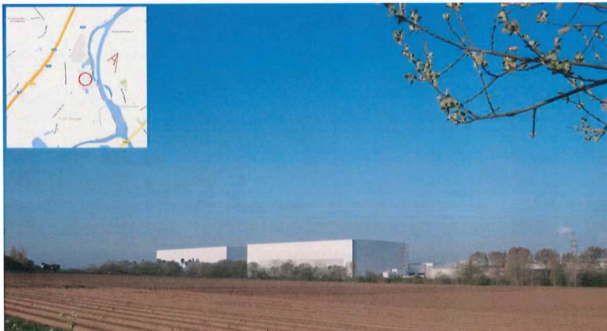
Figure 61 : PM 2 – Vue depuis la rue de la Mine d'Or, au nord-est du périmètre d'implantation du projet (source : CL WARNETON, 2016)
