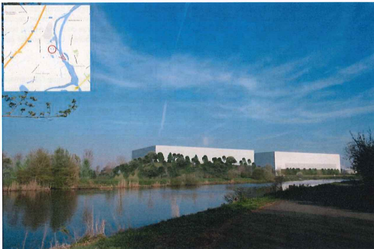
Figure 63 : PM 4 – Vue depuis la rive française de la Lys (source : CL WARNETON, 2016)
