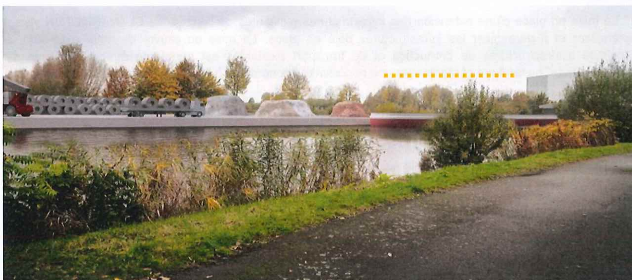
Figure 71 : Vue sur la plateforme bimodale, depuis la berge française de la Lys (source : SPW, 2017)
