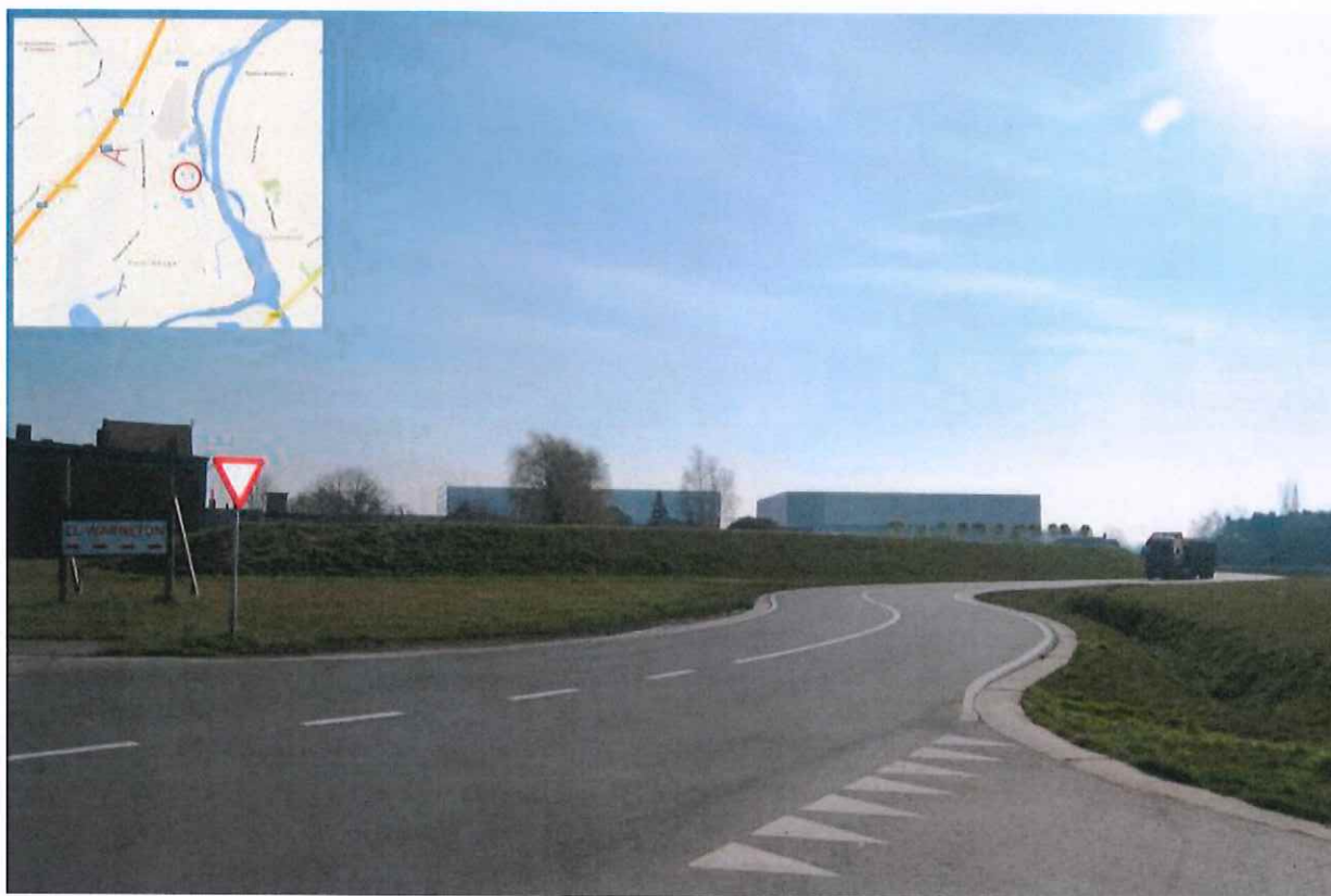
Figure 69 : PM 10 – Vue depuis la voirie d'entrée vers le site de CL WARNETON (source : CL WARNETON, 2016)
